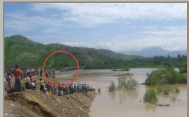
Fig. 8. Ejemplo de baja resiliencia: inicio de desmontaje de puente Carrasquillo (Morropón - Piura) para su rehabilitación en época de lluvias estacionales (febrero 2006).
