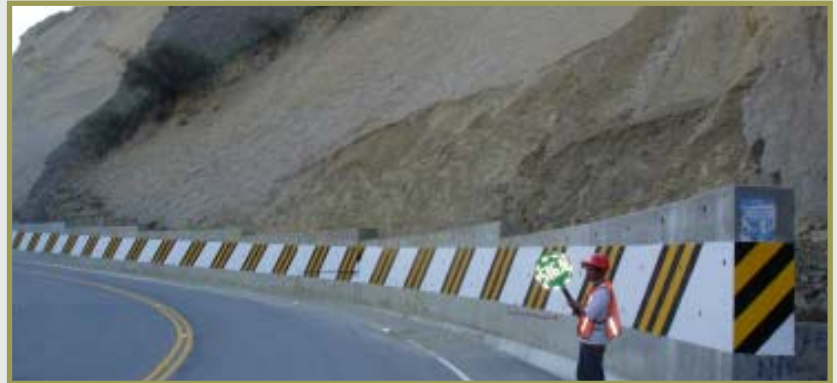
Fig. 24. Construcción de carretera considerando la Gestión del Riesgo: protección de la carretera frente a derrumbes.
