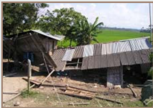
Fig. 11. Viviendas construidas sin tecnología sismoresistente y destruidas por terremoto.
